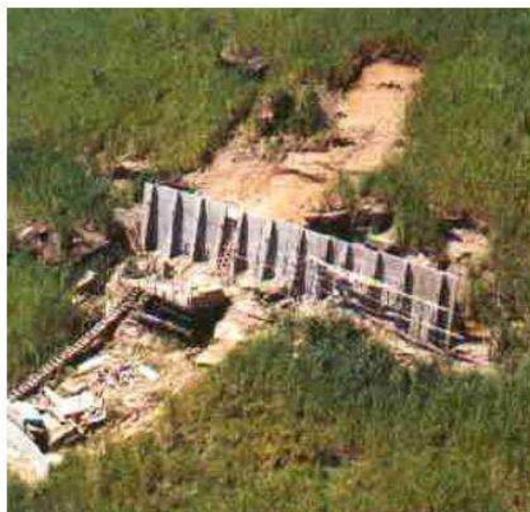
Figura 14 – Muros com contraforte
